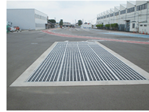
浸水対策（排水口）（宇都宮製作所）
