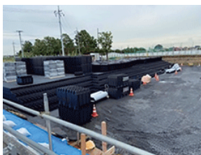
雨水貯留槽設置工事
