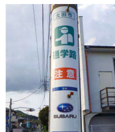
電柱への看板設置
